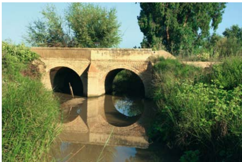
Puente de Robadina sobre el Arroyo Alcarayón.
